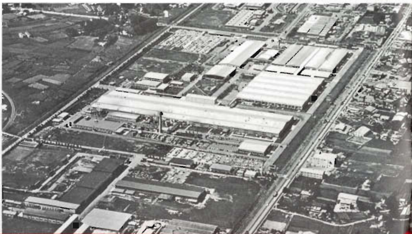
Toshiba Fukaya Werke. Fertigung und Entwicklung von Bildröhren und Farbfernsehgeräten.
